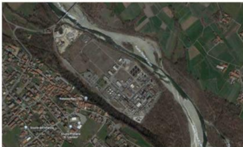
Vista zenitale dello stabilimento ENI e delle aree circostanti
